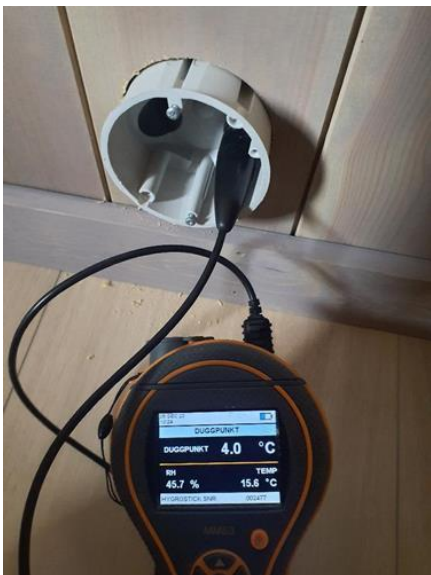
Kommentar - [Hulltaking og fuktmåling i veggkonstruksjonen mot våtsone ved servant, utført fra
